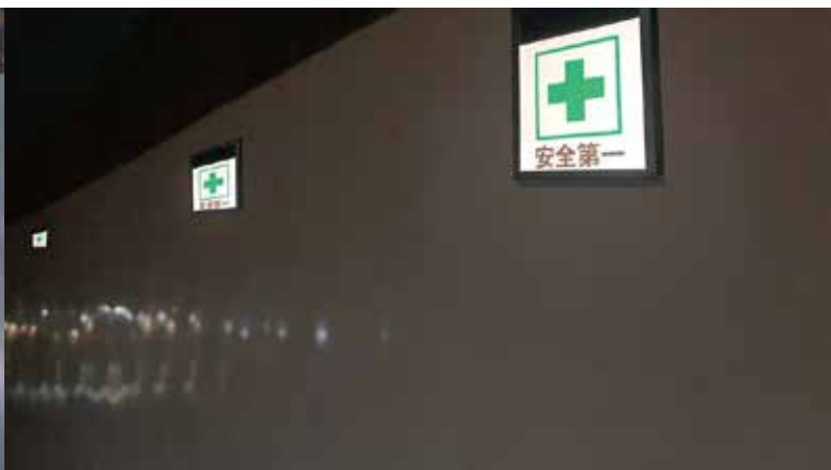
工所用仮囲い
