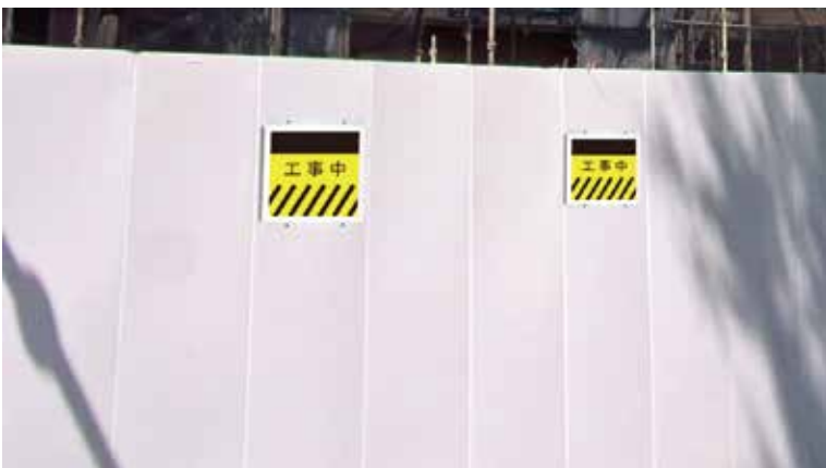
工所用仮囲い
